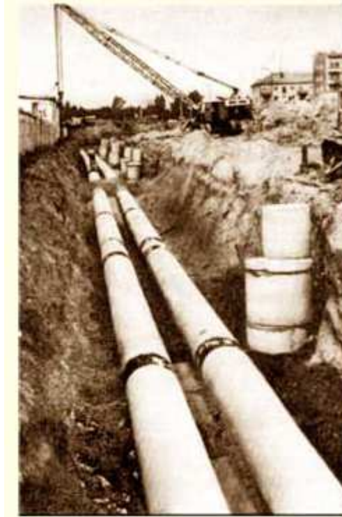
Рис. 3.4. Укладка бесканального теплопровода
