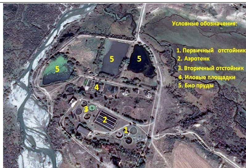
Рис.1. Очистные сооружения города Каракол
